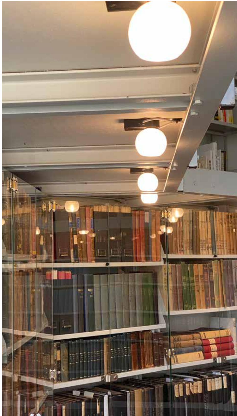
▲ Die installierten Kugelleuchten mit Installationssockel entblenden das Nebenlicht und beleuchten die vorderen Bereiche der schlichten Kugel – wodurch sie im besten Sinne dekorativ wirkt. Foto: Annabelle Schuster, 28. Oktober 2021
