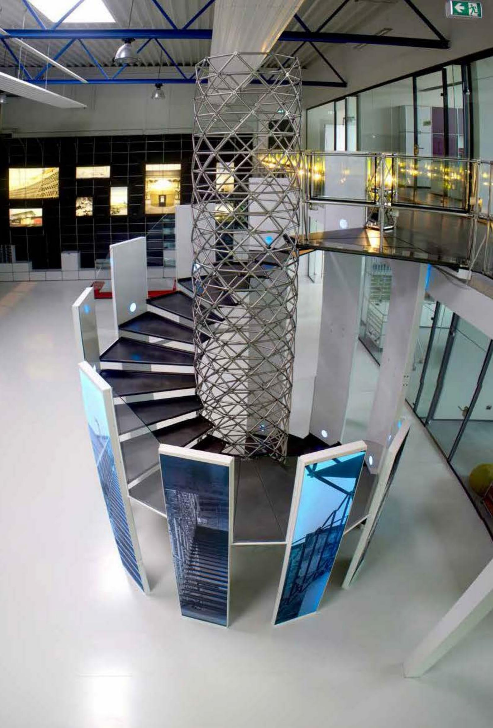
1 Entwurf einer skulpturalen Treppe mit zentralem Zylinder, hinterleuchteten Stahlzargen als äußeren Pendelstützen und gläsernen Geländerfüllungen. Die Treppe führt zu den Büros oben im Luftraum des Showrooms, Jürg Steiner, 9. Oktober 2015.
