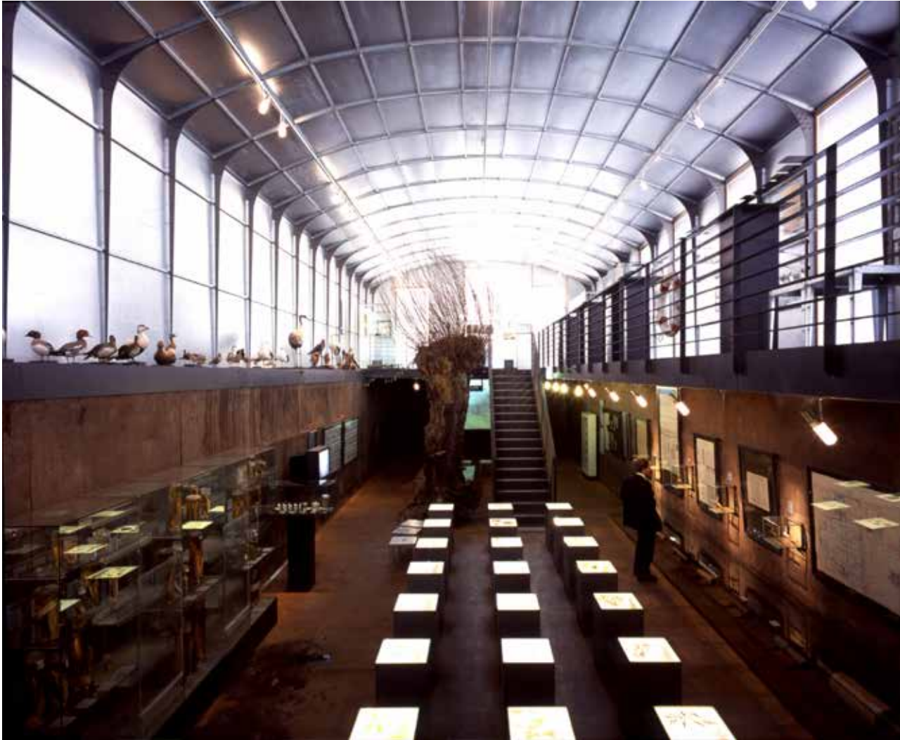
▲ Die Außenwände sind mit verzinkten Blechkassetten ausgefüllt und erzeugen sanfte Reflektionen. ▼ Vom Umgang aus fällt Tageslicht in den Raum und mischt sich mit unterschiedlichem Kunstlicht.
