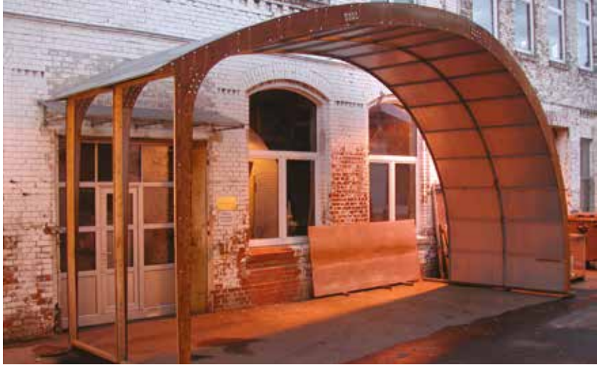
Musteraufbau des Daches für die Schubleichter in Berlin-Schöneberg. Die Statik konnte überprüft und für gut befunden werden, die Materialwahl wurde ebenfalls bestätigt.
