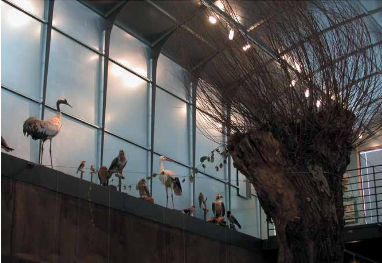
▲ Die Außenwände sind mit verzinkten Blechkassetten ausgefüllt und erzeugen sanfte Reflektionen. ▼ Vom Umgang aus fällt Tageslicht in den Raum und mischt sich mit unterschiedlichem Kunstlicht.
