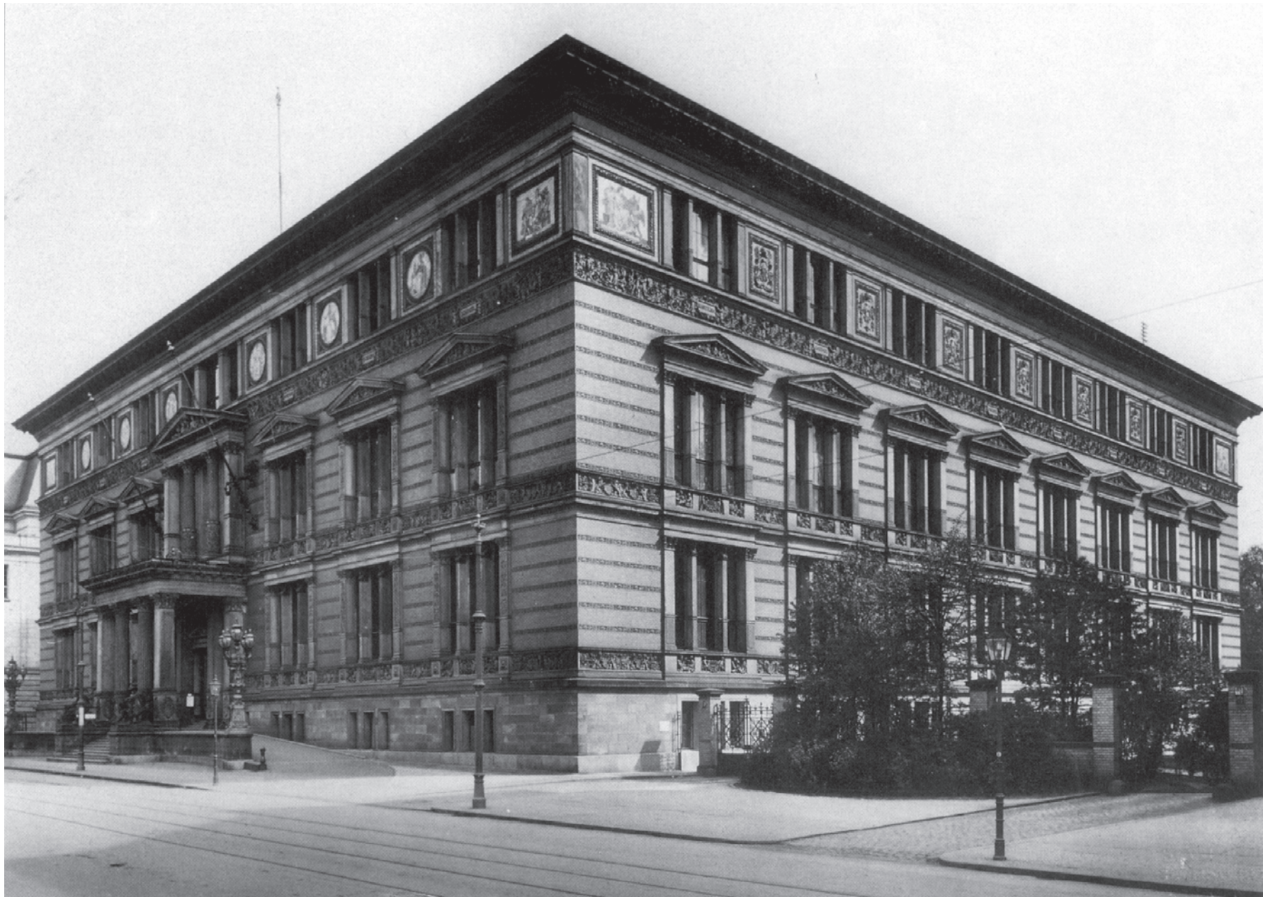
Nordwestansicht des Martin-Gropius-Baus. Aufnahme vor 1945
