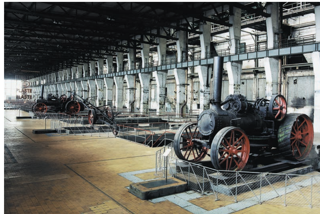
Ausstellung »mittendrin – Sachsen-Anhalt in der Geschichte« im Kraftwerk Vockerode Lokomobile und Madgeburger Kippflug in der Maschinenhalle.
