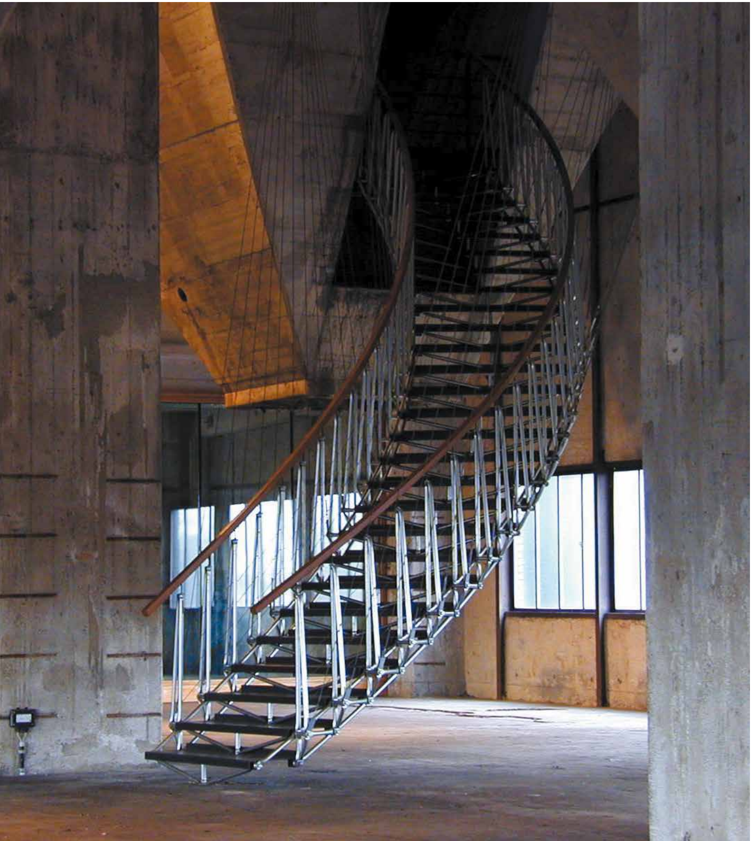
◄ ▲ und ◄ Geländerkonstruktionen im ehemaligen Kraftwerk Vockerode bei Dessau, Foto oben: Christiane Eisler, Transit, Leipzig.
