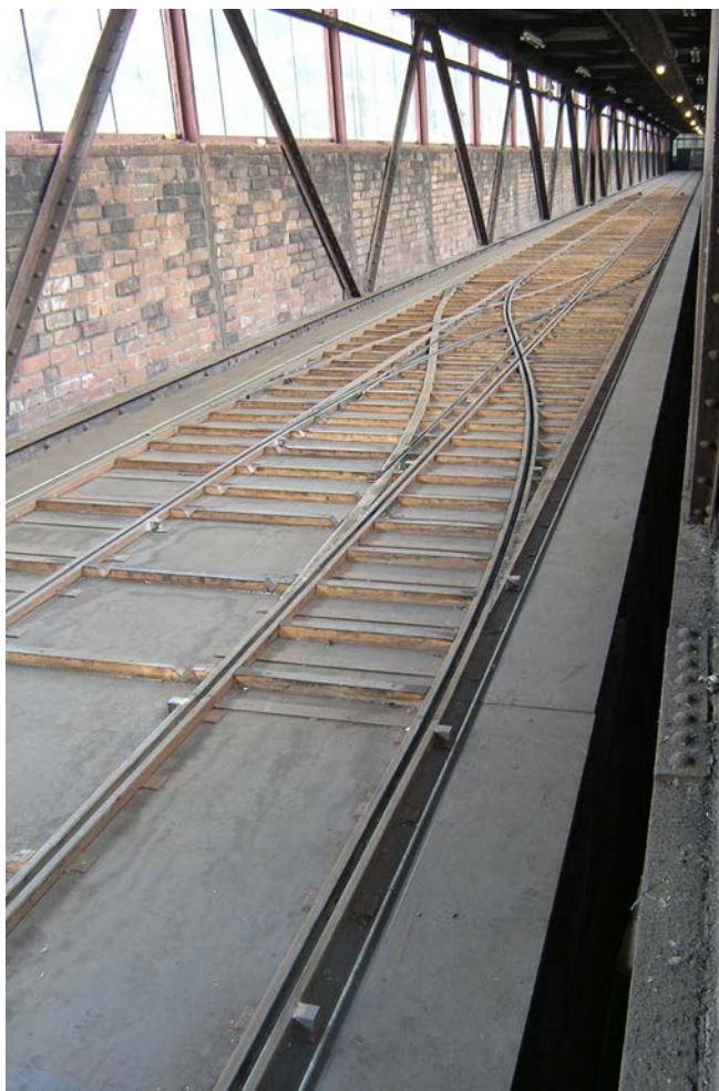
Jeder der vier Wagen wird mit in der Mitte der beiden Räder auf einer Seite angeordneten Spurränzen in seiner festgelegten Fahrt geführt.
