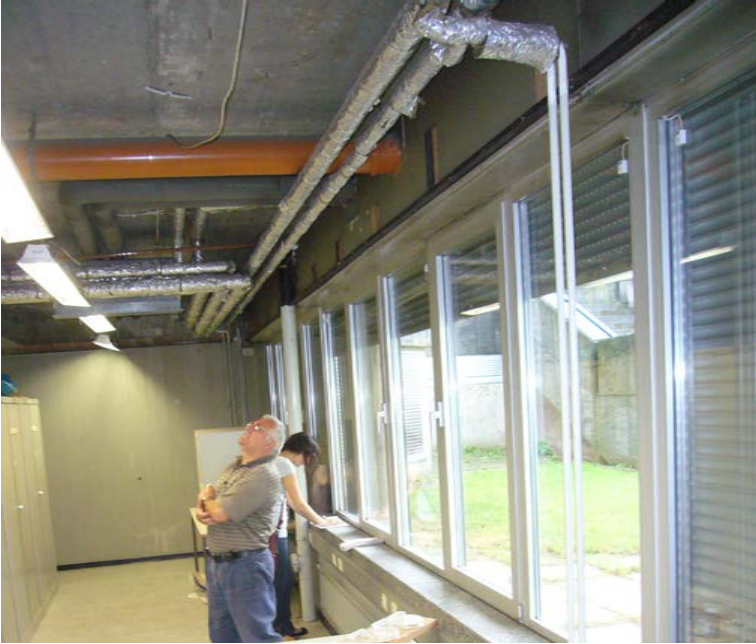
demontierte AHD infolge Wasserschaden FBH / Heizleitung des Wärmtaschers Dachlüftung (Raum 011)
