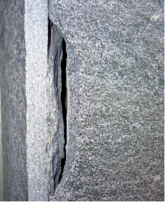
Natursteinfassade Eckstoss gebrochene Kante
