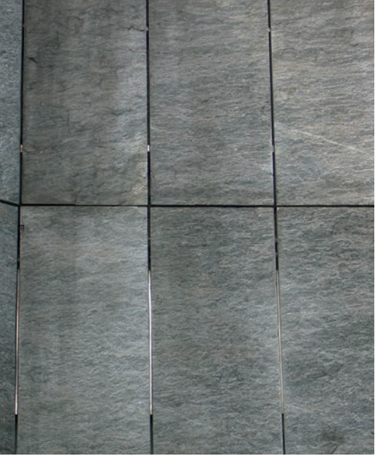
Natursteinfassade Durchblick Edelstahlbefestigung
