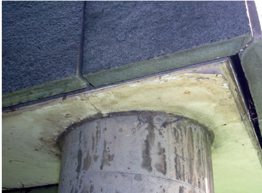
Säulendurchdringung Unterdecke, Wasserschäden durch Wassereindringen in offene Natusteinfugen
