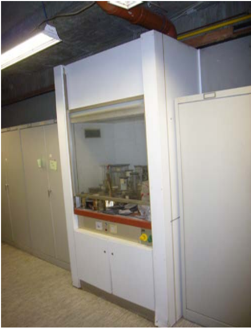
Magazin Zoologie (Raum011) Digestorium mit separater Abluft- abgelöste Sockelblende
