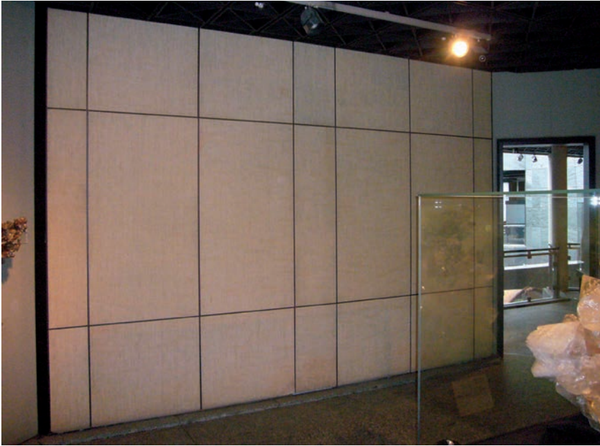
Vorwandpaneele mit Naturfaseroberfläche wie bei Stellwänden (Raum 203)
