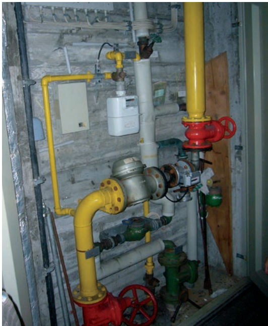
Hausanschlussschrank (Windfang 009A)
