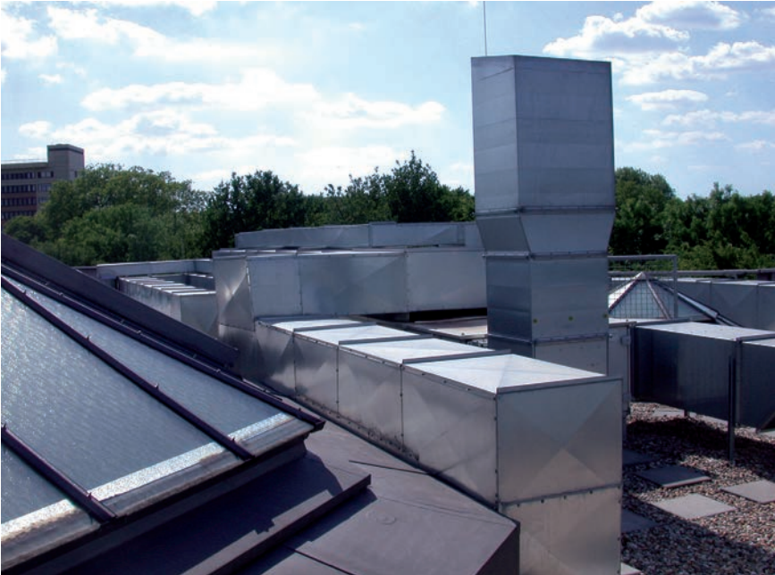
Kombilüftung Wärmetauscher
