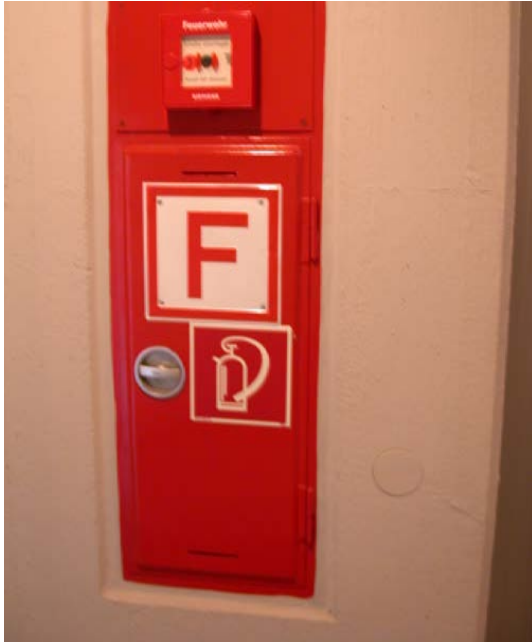
Feuerlöscher / Feuermeldeeinheit Wandnische Treppenhaus
