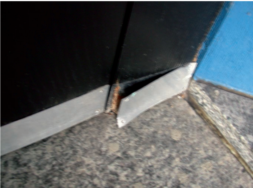
Panneelverkleidung Toilettenräume, defekter Sockelanschluss
