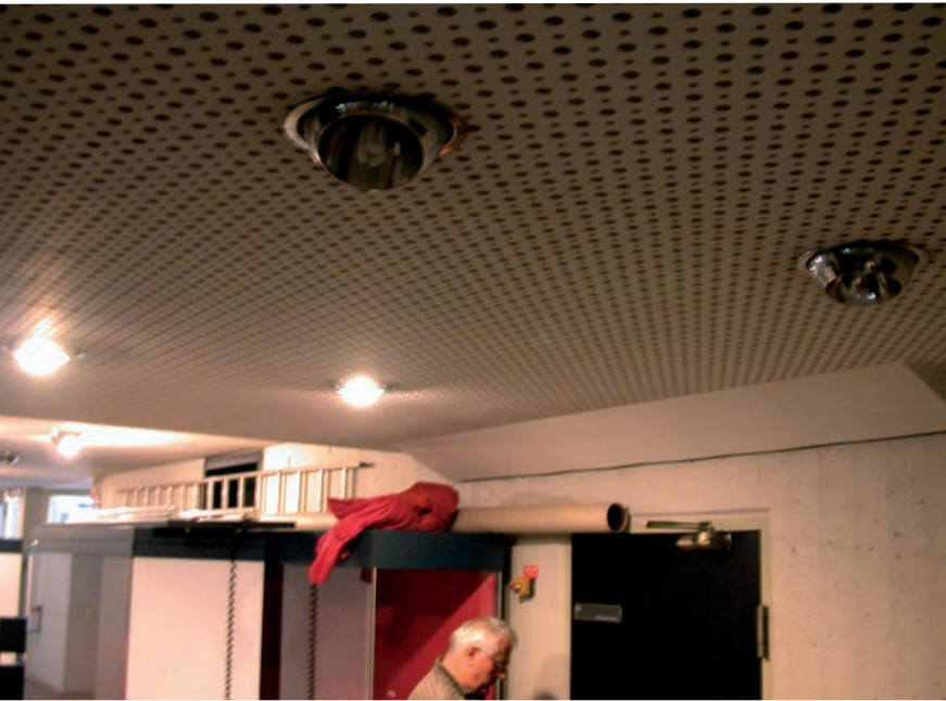
Lochdecke / Gipskarton mit Einbaurichtstrahlern
