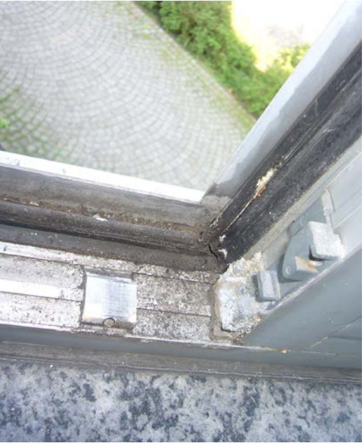
Fensterahmen mit Wassereintrag durch undichte Verglasung
