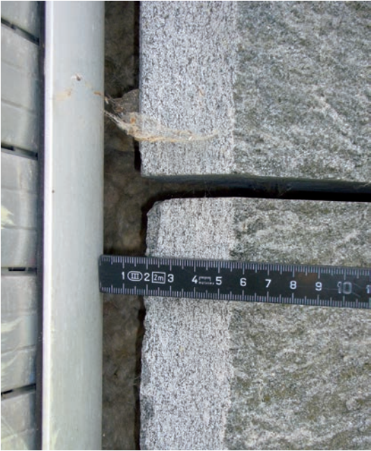
Fensteranschluss offene Fuge, Durchblick auf Dämmung
