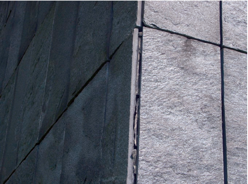
Natursteinfassade Steinplatteneckstoß
