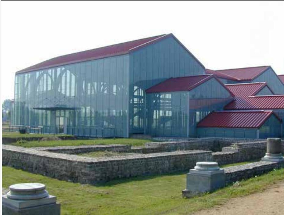
In Xanten am Niederrhein fand man außerhalb der eigentlichen römischen Siedlung die Fundamente einer großen Therme. Bemerkenswert ist der Überbau als Kombination mit Glas und Dachziegeln aus Blech. Im Inneren vermitteln rot angemalte Bögen wohl eine vermutete ehemaligen Gewölbekonstruktion.
