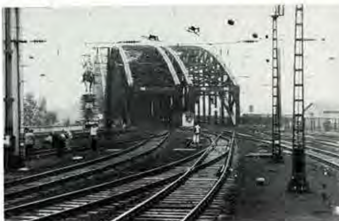
2. den geschwungenen Gleisen zwischen Hauptbahnhof und Hohenzollernbrücke
