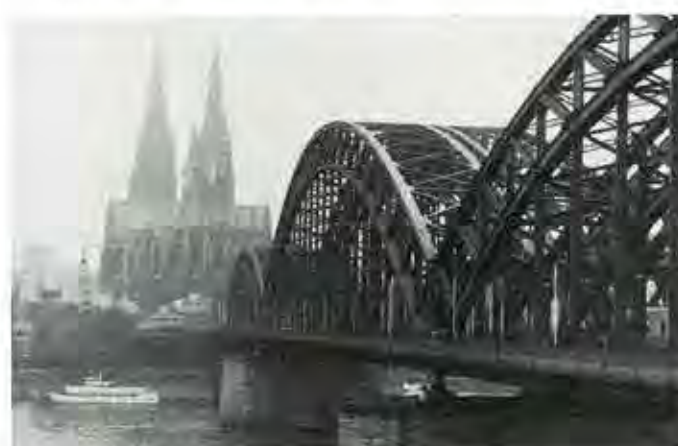
3. der Hohenzollernbrücke über dem Rhein. Jede akustische Zone wird mit Mikrofonen bestückt sein. Fünf werden im Hauptbahnhof installiert, eins auf dem Weg zur Brücke, eins am Eingang zur Brücke, eins in der Mitte der Brücke. Die Geräusche dieser acht Punkte werden gleichzeitig von einem 8-Kanal-Tonband aufgenommen. Am Anhalter Bahnhof in Berlin wird diese 8-Kanal-Aufnahme aus den acht versteckten Lautsprechern zu hören sein. So werden die akustischen Erinnerungen des früheren Anhalter Bahnhofs neben das pulsierende Leben eines zeitgenössischen existierenden Bahnhofs gestellt.
