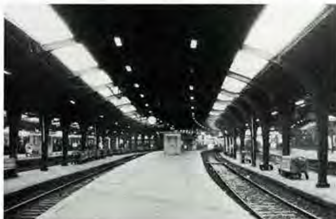
1. dem Inneren des Hauptbahnhofs, entlang der Bahnsteige
