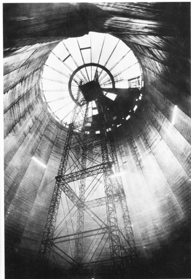
Innenansicht des Gasbehälters der Kokerei Hansa in Dortmund mit Demontagegerüst
