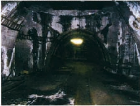
Bild 9: Zollverein 14. Sohle Bunkerfuß
