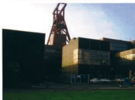
Bild 24: Fördermaschinengebäude und Fördergerüst Schacht 12
