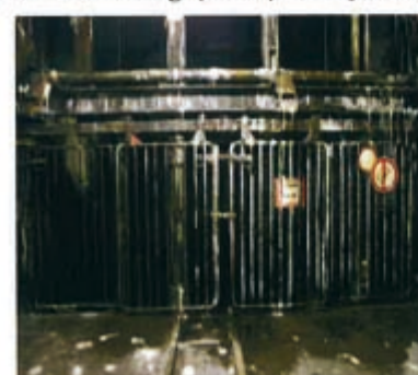
Bild 6: Westlicher Anschlag Schacht 12, 14. Sohle
