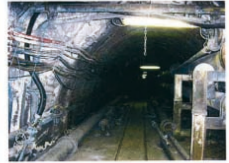
Bild 21: Blick aus der Pumpenkammer in Richtung Schacht 2
