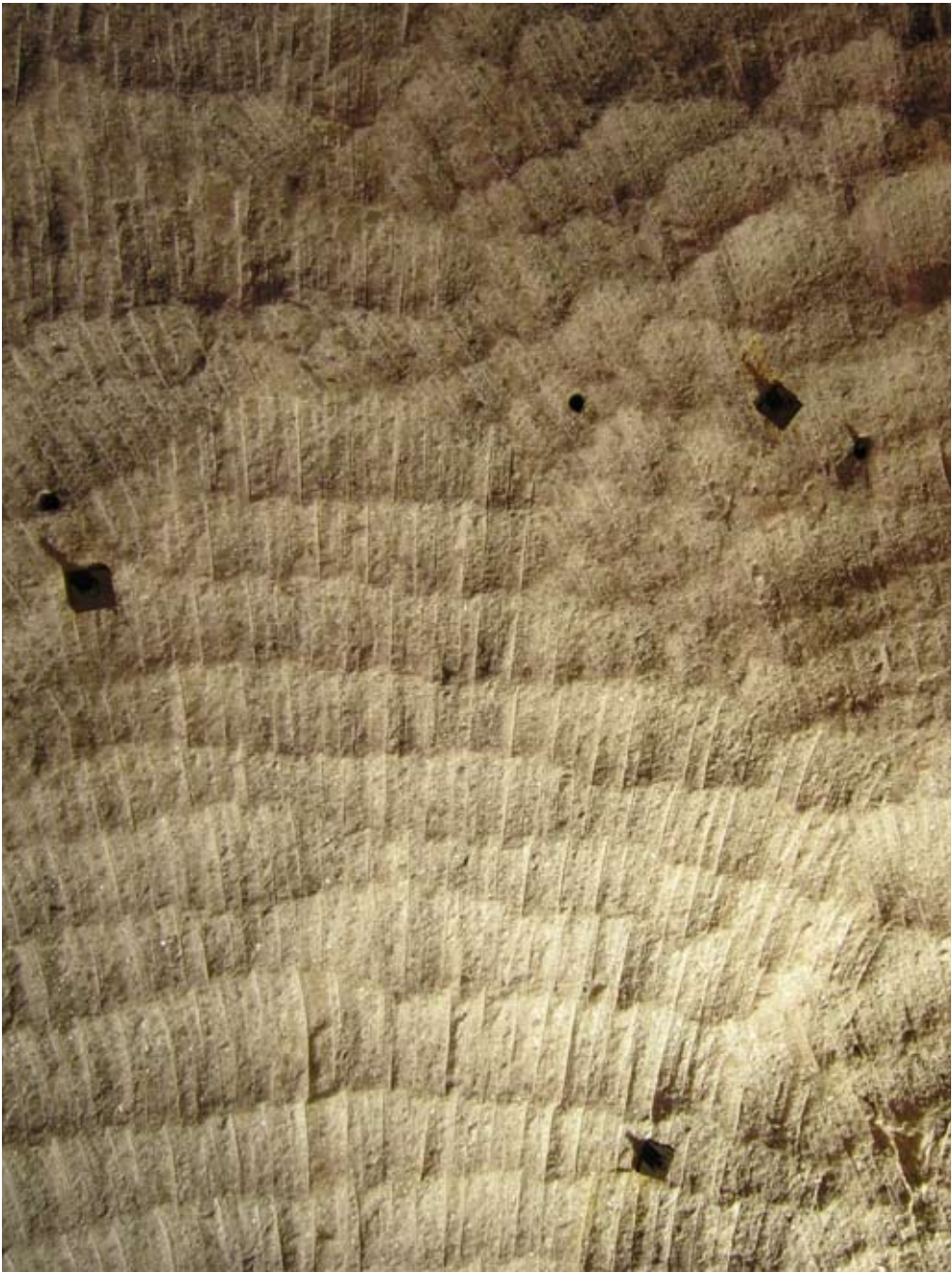
Erlebnisbergwerk Glückauf Sondershausen Steinsalzdecke in einer streichenden Strecke, 10. Januar 2009
