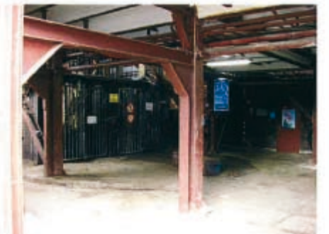
Bild 23: Schacht 12, Anschlagbereich Rasenhängebank
