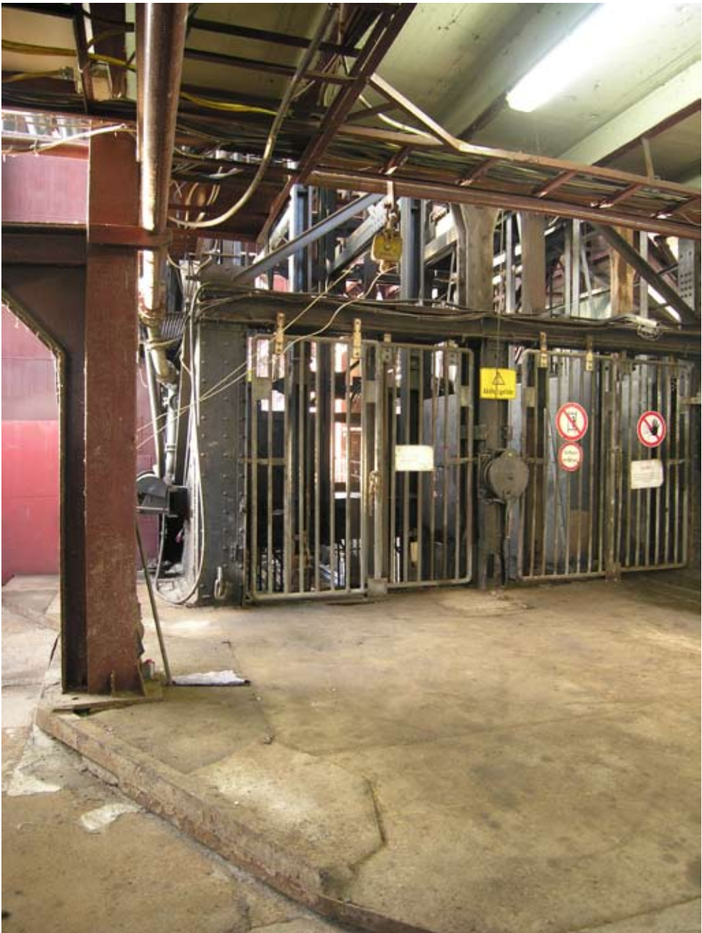
1.6.1 Schacht Zollverein 12, Ebenerdiger Anschlag
