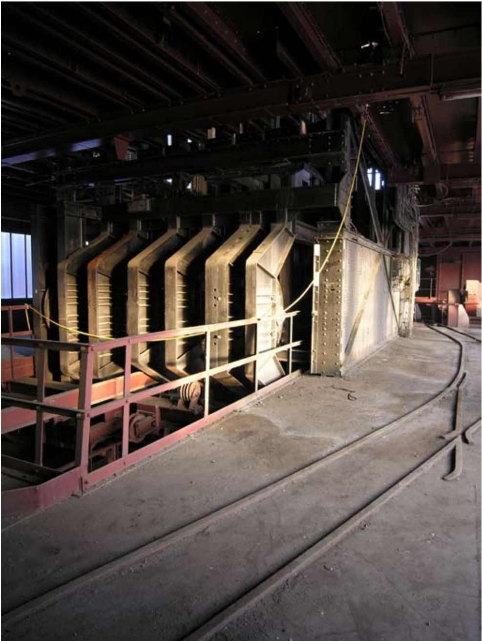
1.6.2 Oberster Satz im Wagenumlauf, umgerüstet auf Skip-Förderung
