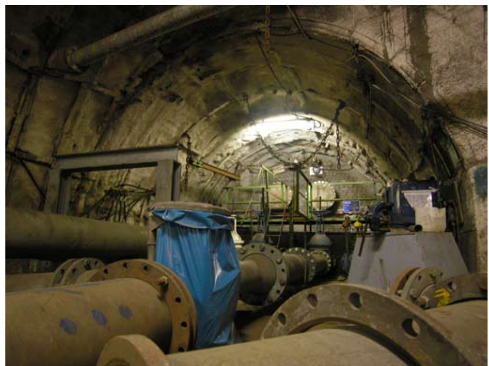
1.5.5 Strecke Sohle 14, kurz vor der Pumpenkammer mit Blick Richtung Süden zum Wasserdamm 512
