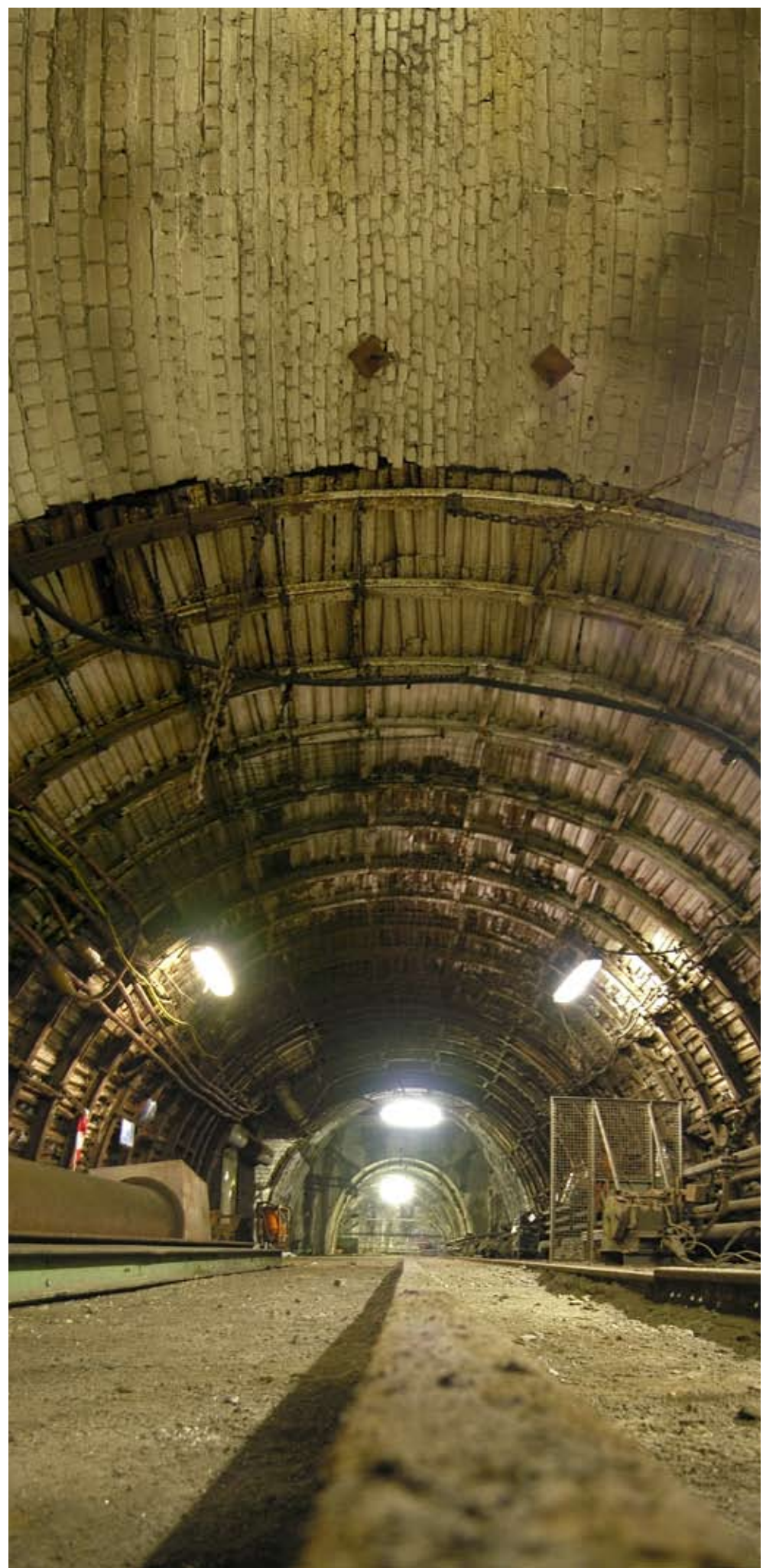
1.5.4 Strecke Sohle 14, zweiter Abschnitt Blick Richtung Westen
