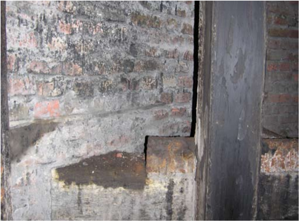
1.4.1 Schachtwand und Spurlatte aus Holz
