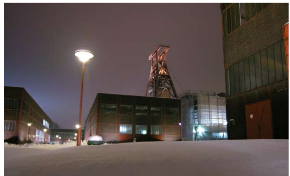
1.1.2 Das eingestülpte Fördermaschinenhaus, 7. Januar 2009
