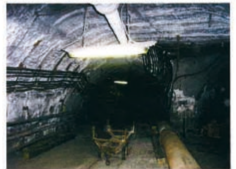
Bild 19: Zollverein Qu. 6, 12,6 – 14,9 m 2 zwischen den Wasserdämmen
