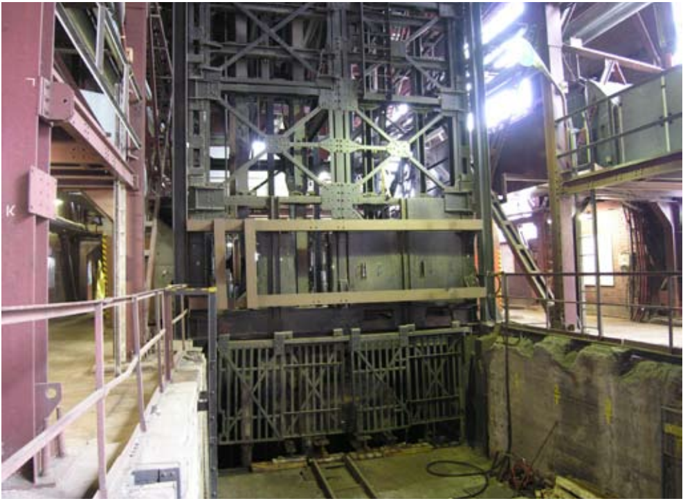
1.2.2 Am Anschlag über Tage
