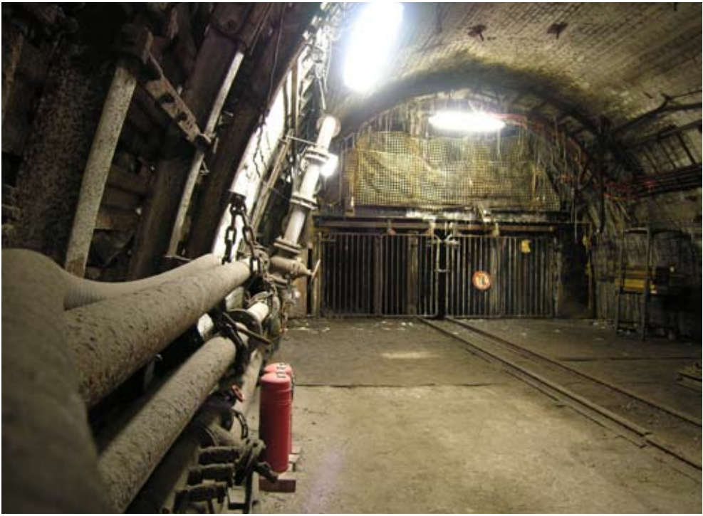
1.5.1 Anschlag des Schachtes 12 auf Sohle 14 (-950 m)
