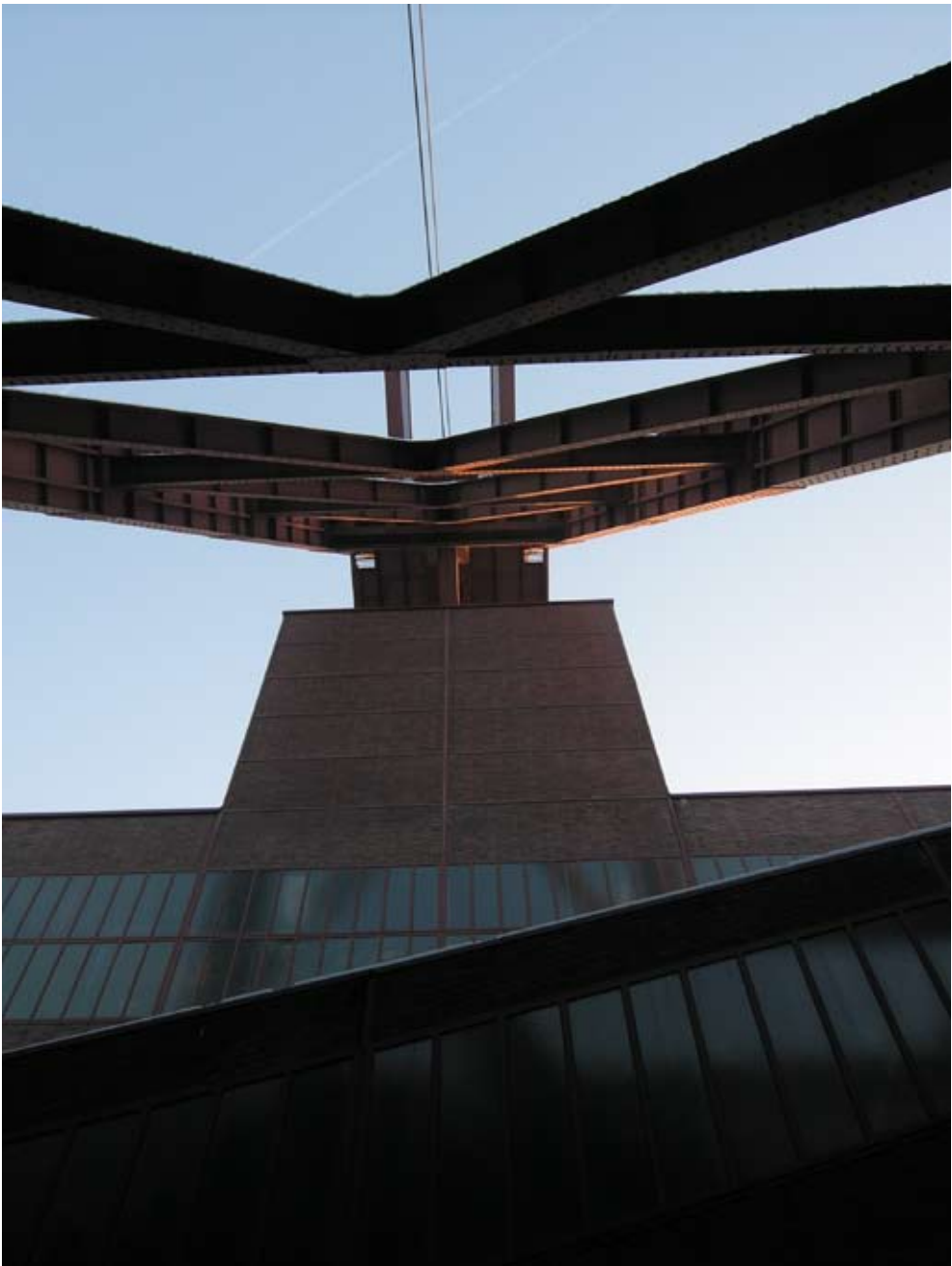
1.6.3 Fördergerüst des Schachtes 12 nach dem Verlassen des Anschlags mit den beiden Seilen, die zum Fördermaschinenhaus führen.
