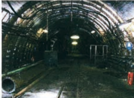
Bild 8: Zollverein, Blick vom Anschlag Schacht 12 nach Westen
