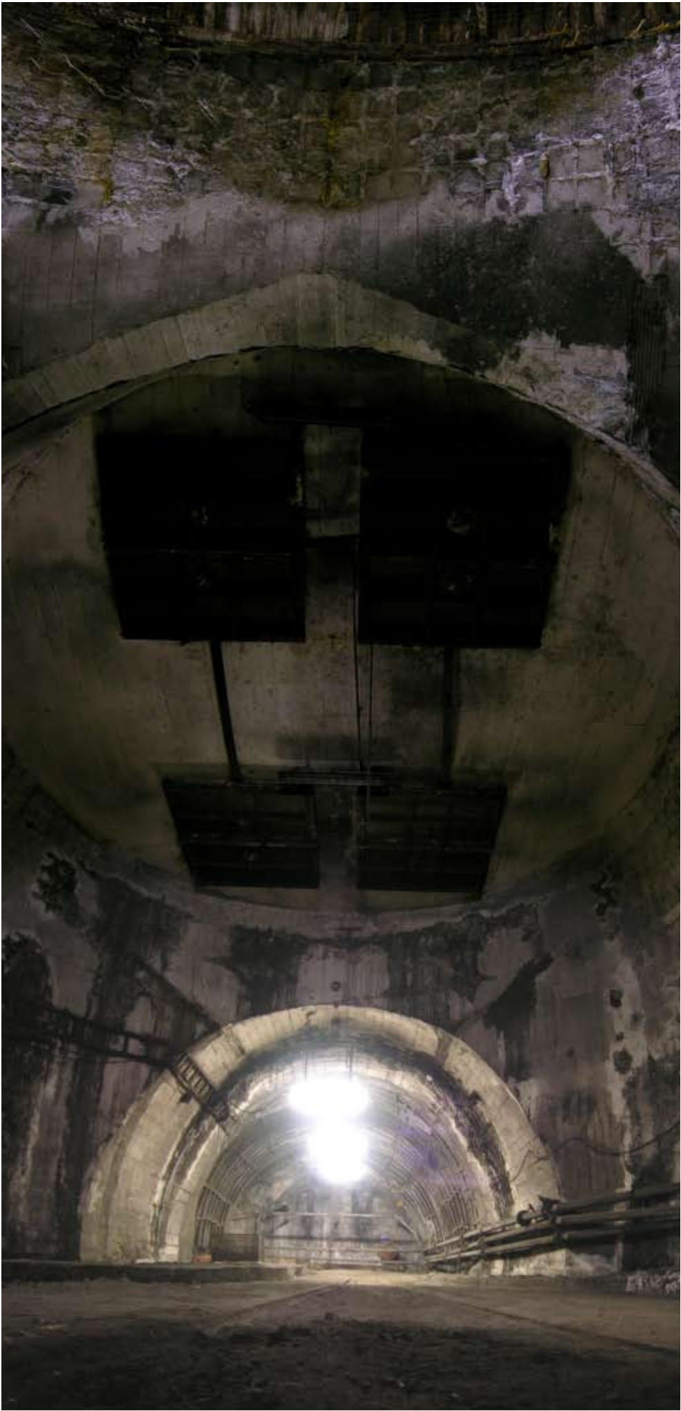
1.5.2 Am Anfang der Strecke, Richtung Westen, kurz vor dem Bunker
