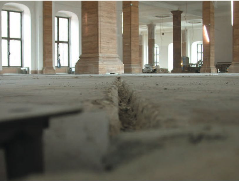
Obergeschoss des Berliner Zeughauses: Bodentank mit Schlitzung Aufnahme: 3. Juli 2002
