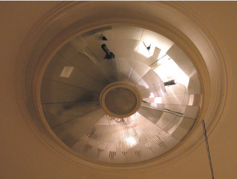
Rosettenleuchten des Berliner Zeughauses mit neuer und originaler Verglasung (am unteren Bildrand). Aufnahme: 18. Dezember 2001
