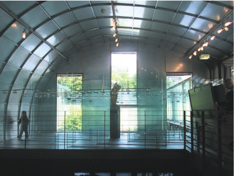
Rauchabzugsfenster (Mitte oben) und Nachströmöffnungen (Türen rechts und links) in der Ausstellung Wasser~Fälle. An Rhein und Maas in Düsseldorf, Aufnahme: 16. Juni 2002
