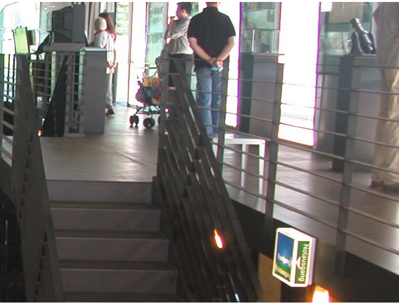
Not- und Hinweisleuchte in der Ausstellung Wasser~Fälle. An Rhein und Maas in Düsseldorf Aufnahme: 16. Juni 2002
