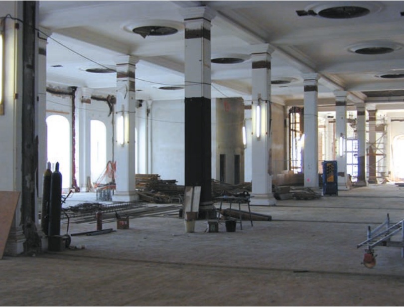
Das Berliner Zeughaus während den Sanierungsarbeiten Stand: 31. März 2001
