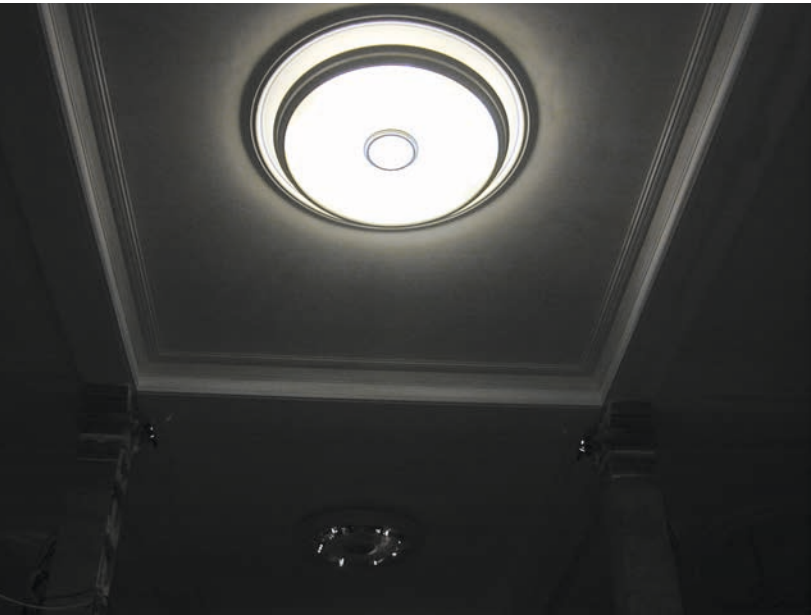
Rosettenleuchte wie sie bauseits bemustert wurde. Ein vergleichsweise heller Lichtkörper schützt eine »Lichtsuppe« aus. Die Decke bleibt unbeleuchtet.
