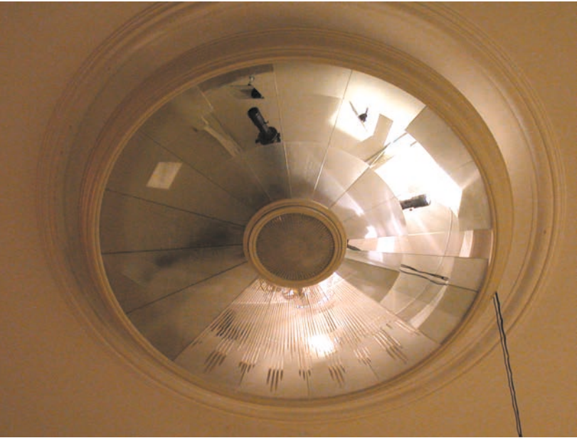
Rosettenleuchter des Berliner Zeughauses mit veränderter und originaler Verglasung (am unteren Bildrand). Aufnahme: 18. Dezember 2001
