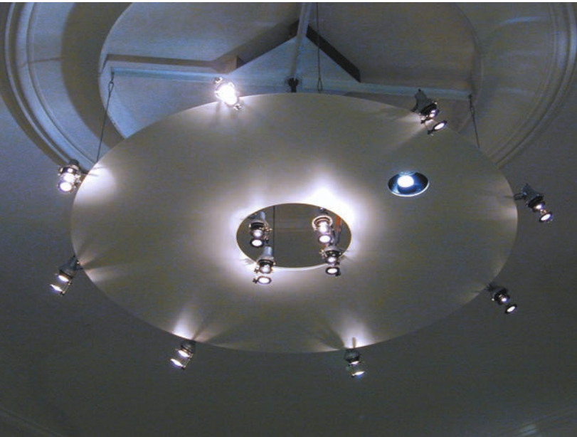
Saturnring während der Beleuchtungsprobe am 18. Dezember 2001 bestückt mit Konturstrahler »Pollux« der Firma erco und einem »Scanner« der Firma Scenario
