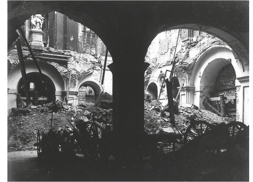
Zerstörungen durch Fliegerbomben im Zeughaus Aufnahme 1944
