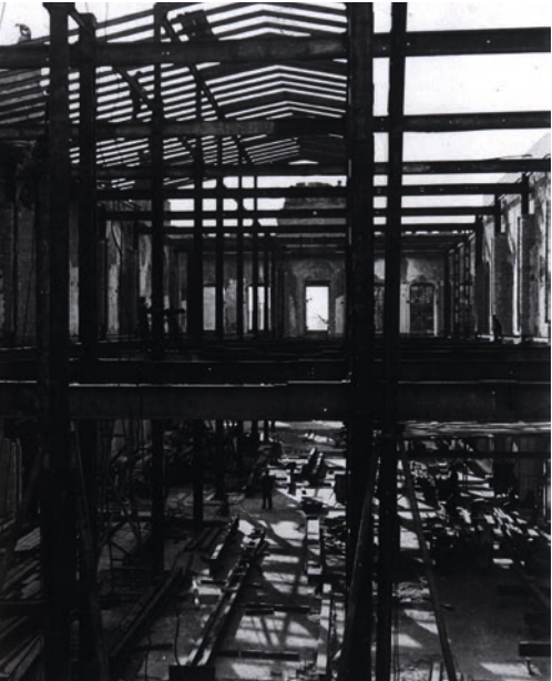
Der Einbau des Stahlskeletts in den Südflügel Aufnahme Ende 1950
