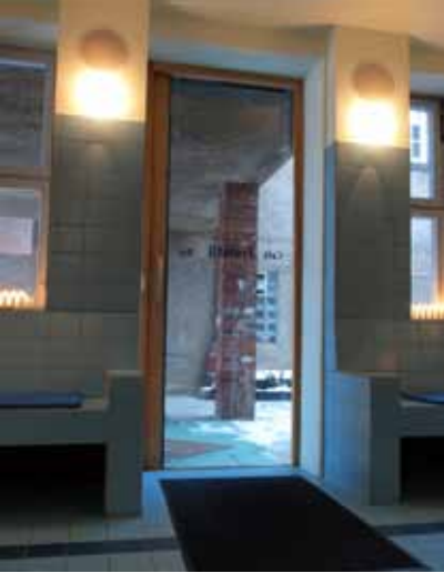
▲ Die Tür zum Höfchen rahmen mattierte Glasku- geln mit unterer Bohrung zur Eigenreinigung ein.
