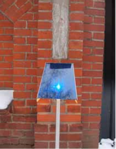
▲ Die Abdeckscheibe der Aussenleuchten verhin- dert Blendung und erzeugt ein blaues Nebenlicht.
