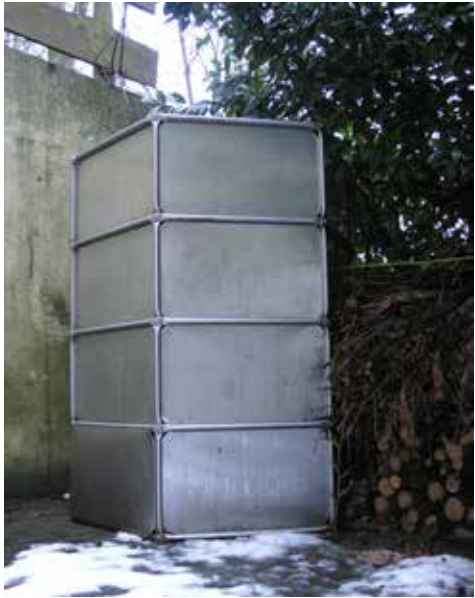
◀ ▲ ▲ Holzlagergestell an der Ostwand der Heerstrasse 97 aus Edelstahlrohr mit Durchmesser von 20 mm, Aufnahme 22. Januar 2015
