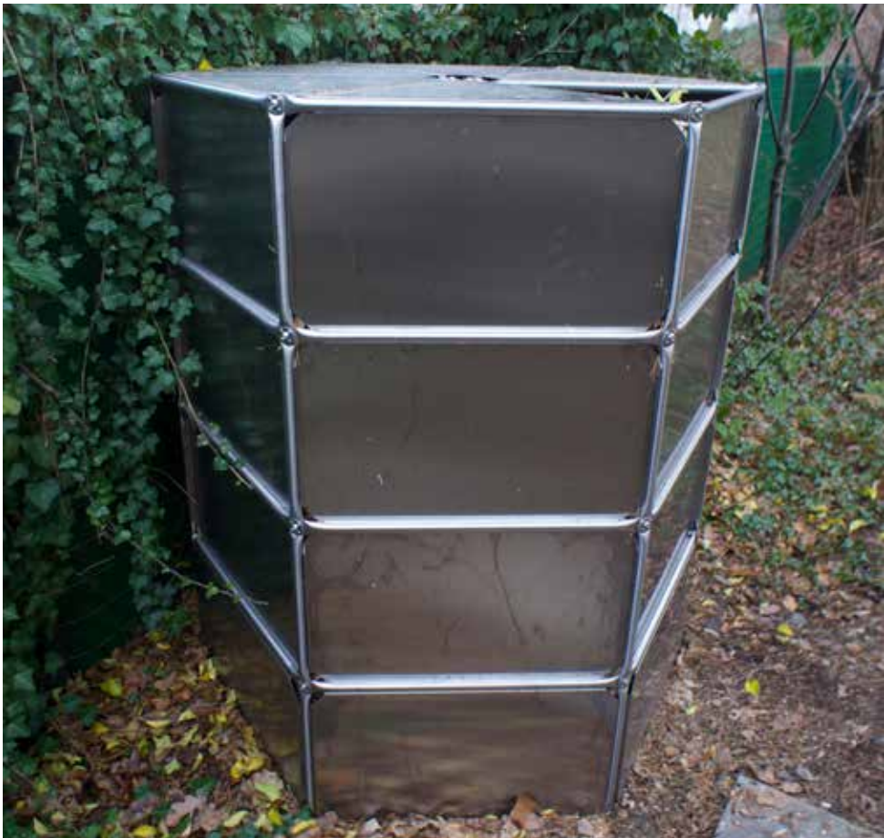
◀ ▲ ▲ Holzlagergestell an der Ostwand der Heerstrasse 97 aus Edelstahlrohr mit Durchmesser von 20 mm, Aufnahme 22. Januar 2015
