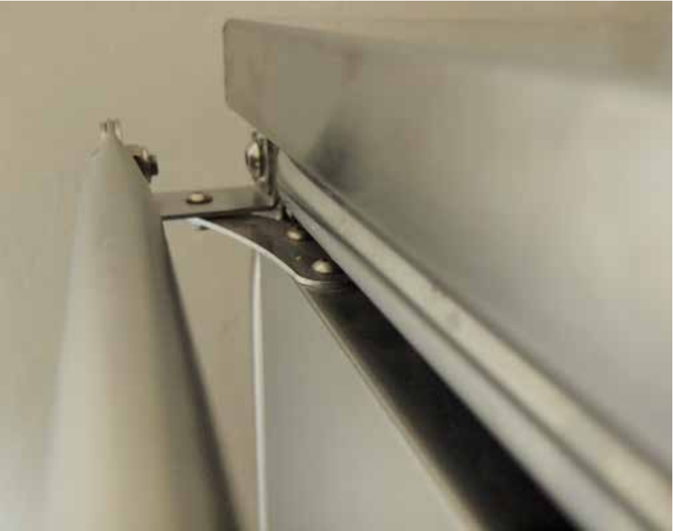
◀ ◀ Prototypküche Mark 3 in der Schmargendorfer Straße 6, Berlin-Friedenau am 13. April 2007. Im Gegensatz zu den beiden Vorgängerprototypen von 1990 und 2002 wurde gänzlich auf Holzwerkstoff verzichtet und ausschließlich Edelstahl verwendet, die weißen Objekte waren vorhanden. Besonderheit ist das durchgehende zusätzliche Rohr auf Arbeitshöhe und Unterkante Oberschrank zum Festhalten, Anhängen von Gegenständen und Trocknen von Geschirrtüchern, Aufnahme 13. April 2007. ◀ Küchendetail, 5. April 2010: Neben dem zweiten horizontalen Rohr ist Besonderheit das außenliegende Scharnier, das den Drehpunkt mitten im Rohrhalbwinkel hat und dadurch die Tür ohne Federn oder ähnlichem an jeder Position hält.
