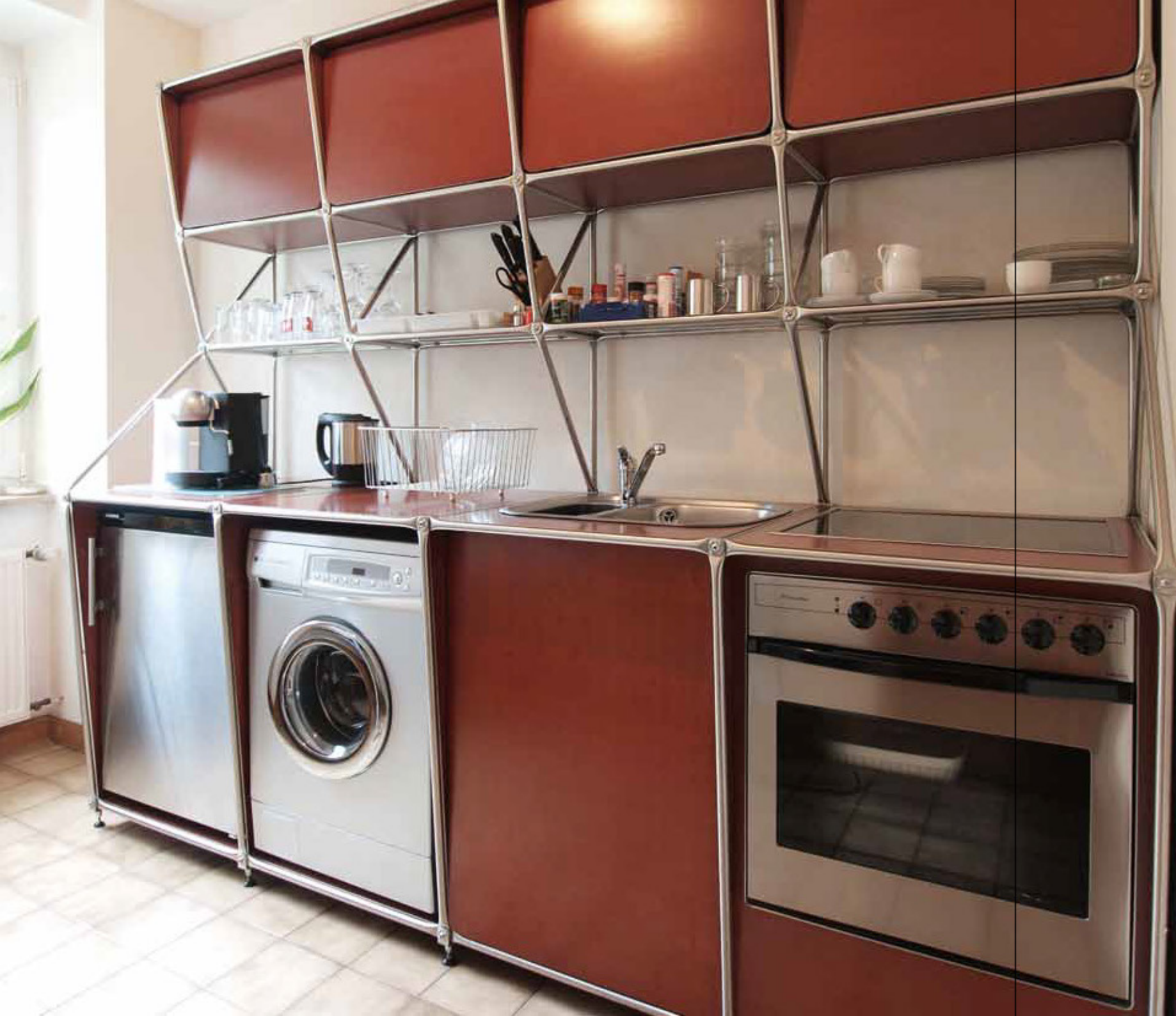
Selbststehende Musterküche aus Edelstahlrohr mit Betoplan-Füllungen, 2002
