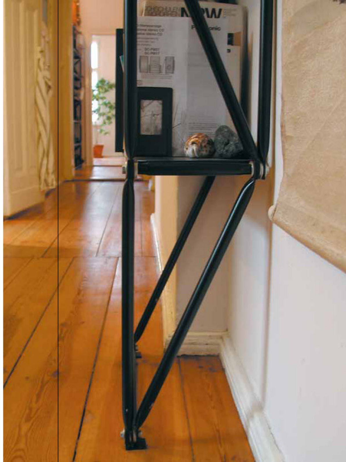
Schwarz lackiertes Regal aus schlankem Rohr als Vorläufer der Serie im Durchmesser von 20 mm (hier speziell für Wohnungen mit großen Fußleisten), 1993
