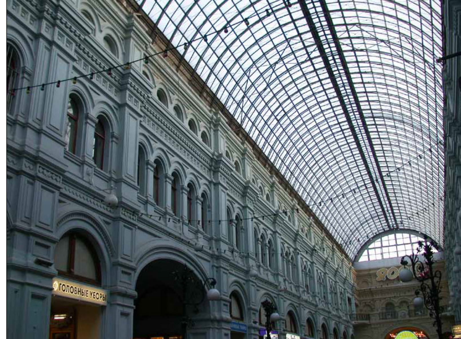
Das von Schuchow stammende Glasdach des bekannten Moskauer Kaufhauses GUM
