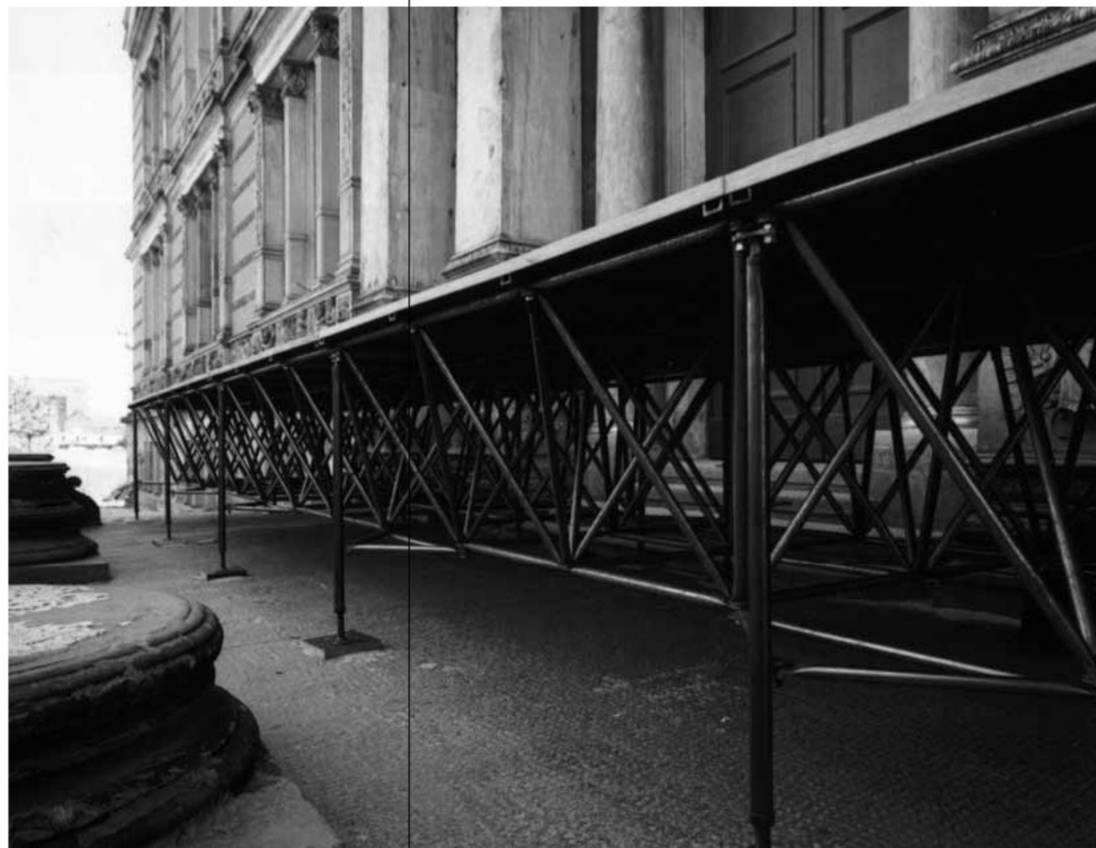
Martin-Gropius-Bau Berlin, Transportrampe für die Anlieferung von Kunstgegenständen am Nordportal, 1989
