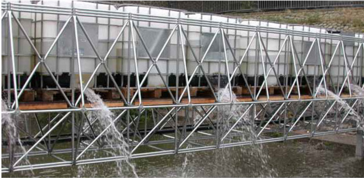
Zugangssteg zur Ausstellung „Wasser-Fälle. An Rhein und Maas“, Medienhafen Düsseldorf 2002 Oben: Nach bestandener Belastungsprobe am 11. Juni 2002
