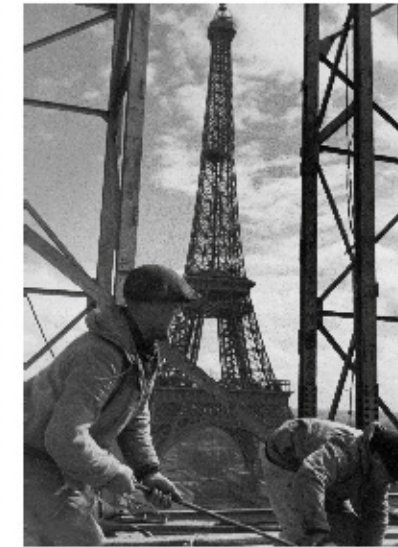
Oben: Frankreich, Paris, Weltausstellung, Deutscher Pavillon im Bau, Aufbau des 54 m hohen Stahlgerüsts, im Hintergrund der Eiffelturm, 1937 Links: Eiffelturm, Paris, Bau der Stahlkonstruktion, 1887/89
