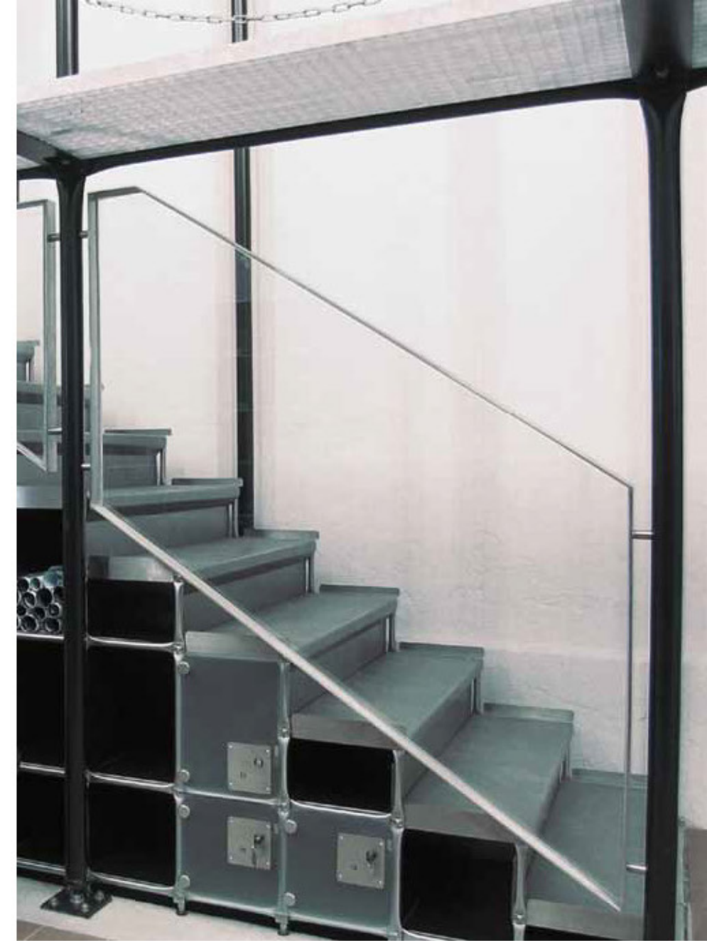
Kombinierte Treppe mit Schließfachanlage aus Edelstahlrohr mit einem Durchmesser von 20 mm, Brauerei Museum Dortmund 2006
