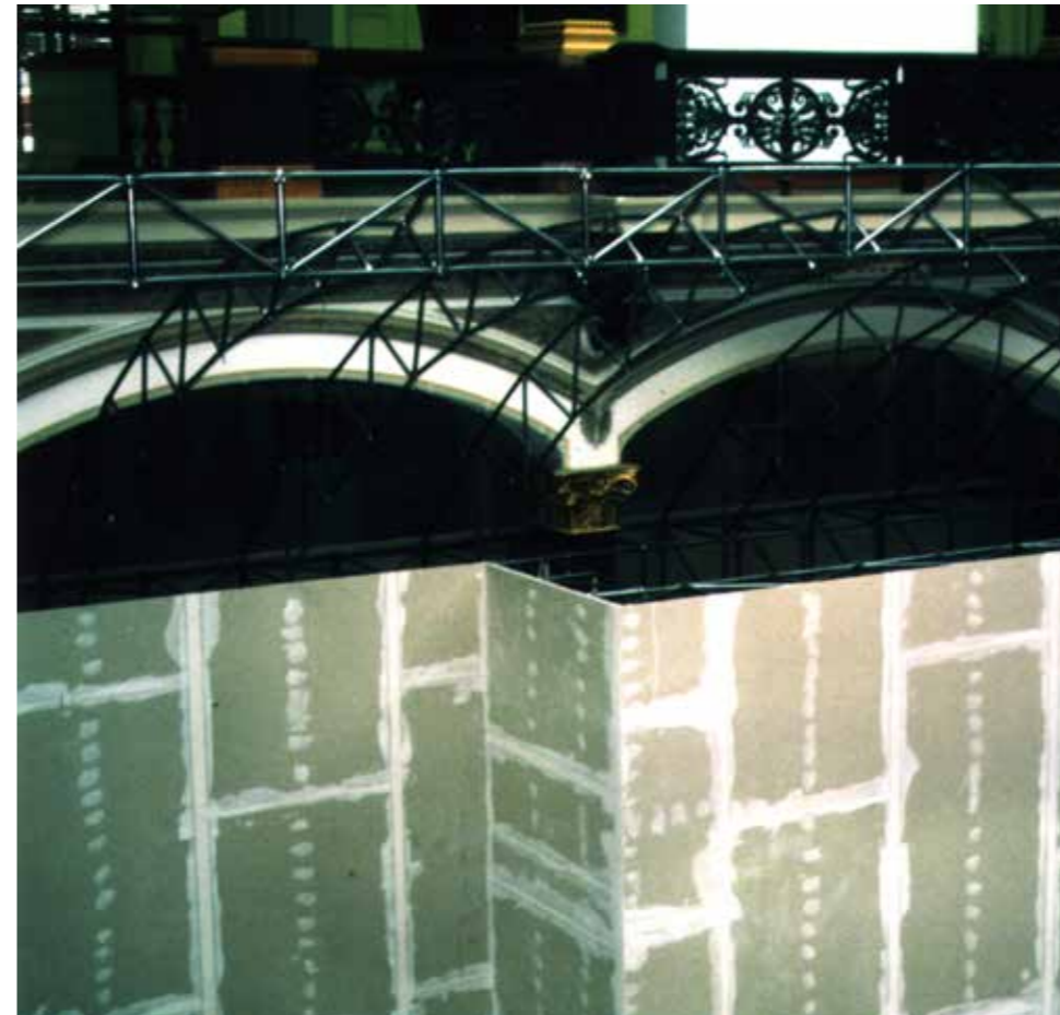
Dank der Konstruktion aus System 180 wächst das Glasdach gleichsam aus den Wänden heraus. Die vertikalen Stäbe des Systems in den Wänden bestehen aus ›Systemholz‹, das aus einer Verbindung aus Flachstahl 40/1,5 und einer 40 mm breiten Holzleiste gebildet wird. So können Gipskartonplatten einfach montiert werden. Fotos des Aufbaus, Archiv System 180 GmbH.
